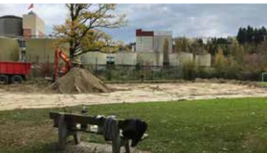
Aushub im Oktober 2017
